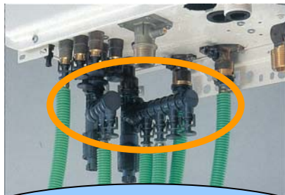
温水器ジョイント
